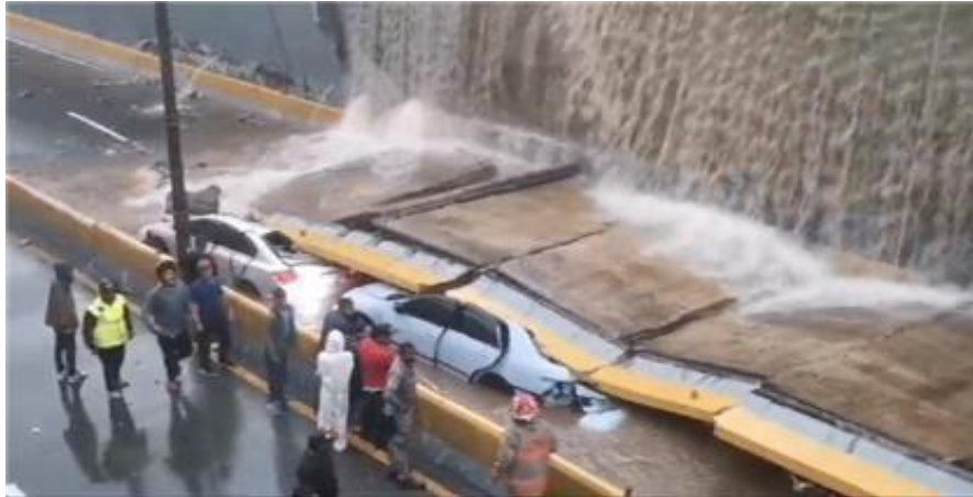
Colapso del paso a desnivel en la Avenida 27 de Febrero (noviembre 2023) Fuente: periódico Listín Diario
